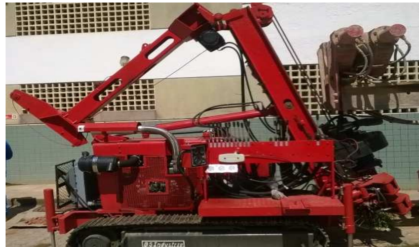
Perfuratriz hidráulica (estaca raiz).
